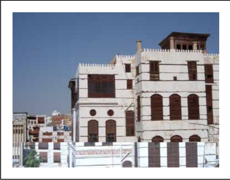
الواجهة الشرقية لبيت البسيوني بحارة اليمن
